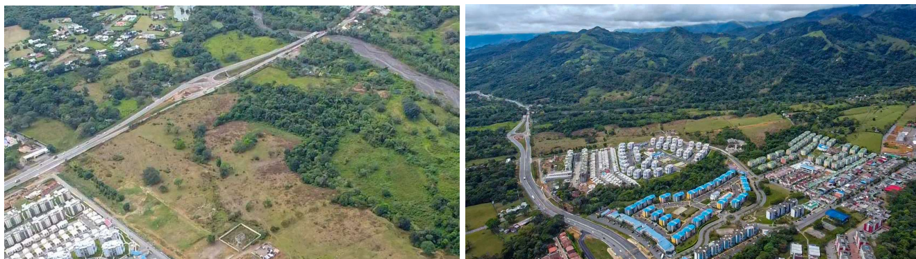
Izq: Macrolote proyectos Balcones de la Rivera y Balcones del Rio con Reserva Ecológica al costado derecho. Der: Gran Proyecto Balcones con más de 2.700 Un de Viviendas construidas.
